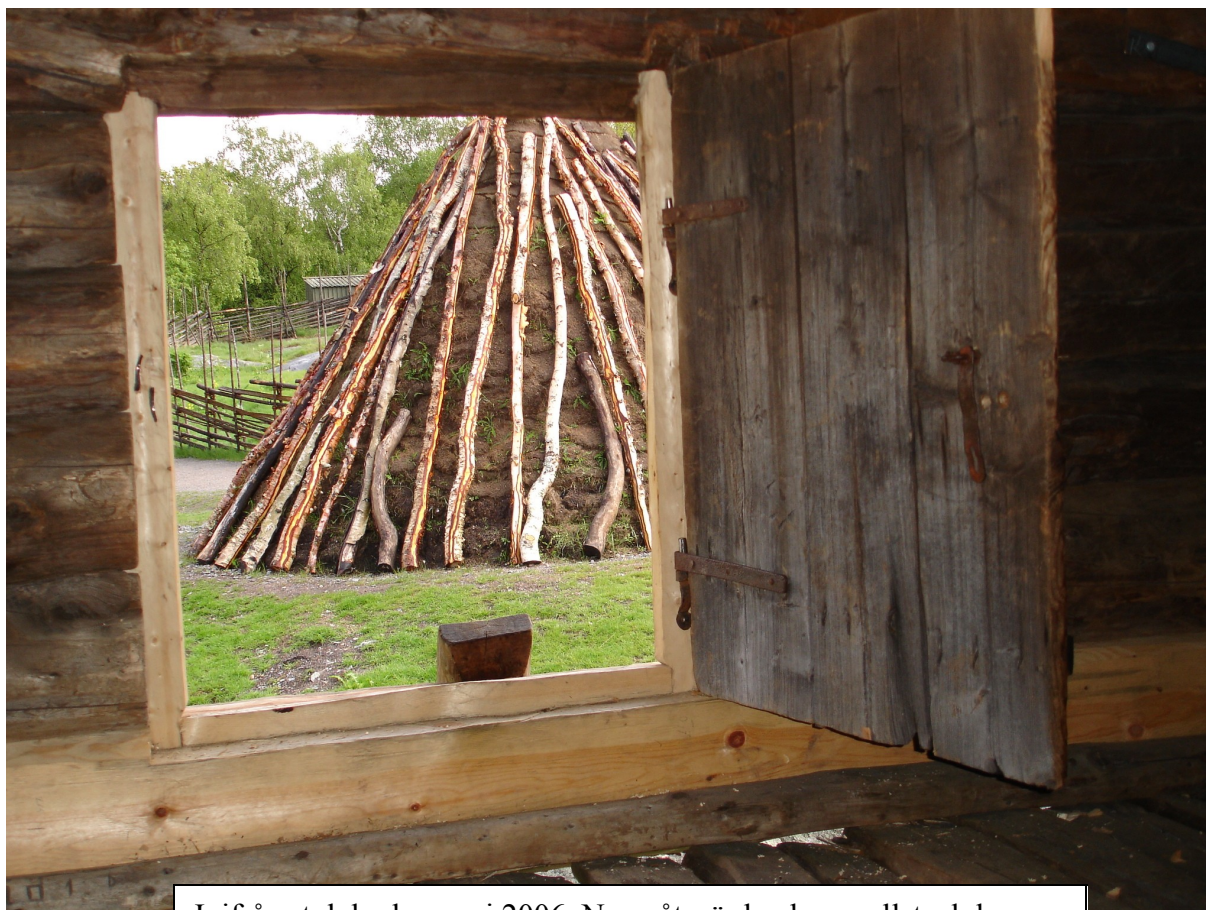
Inifrån stolpboden, maj 2006. Nya gåtsvärd och ny syllstock lyser mot det gamla. Nederst i bild en av socklarna som håller det lösa golvet på plats.
