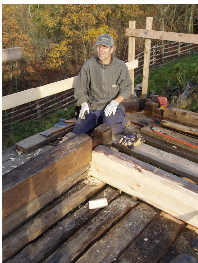
Olof med den främre utbytta gavelsyllstocken. Golvet ligger löst på bärlinorna, och ska hållas från att vippa genom en grov list som spikas över golvträändarna i båda gavelsyllstockarna.
